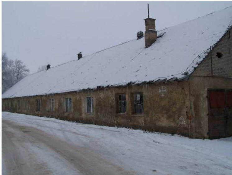
Rys. Nr 3. Budynek starego internatu
