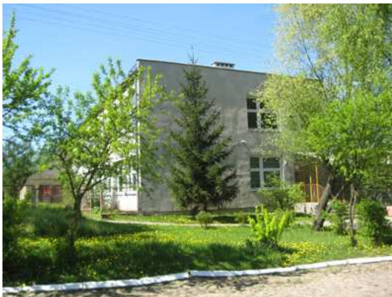
Rys. Nr 5. Budynek szkoły nr 2
